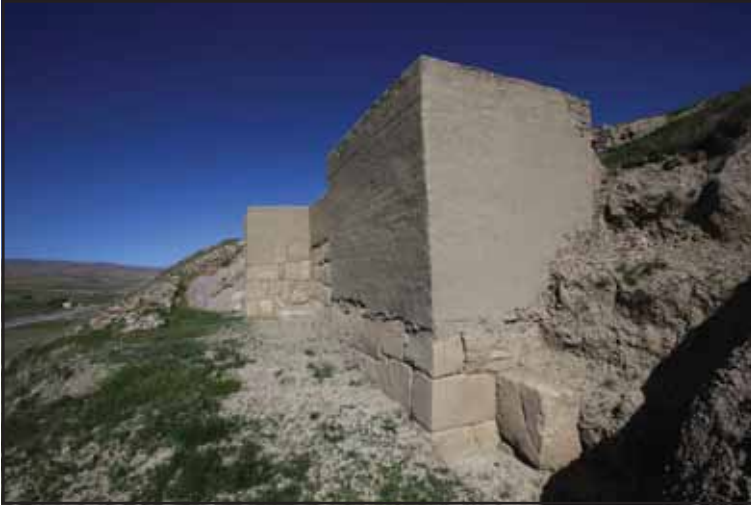
Resim 7: Depo I ve II'nin kuzey duvarının onarım sonrası genel görünüşü.
