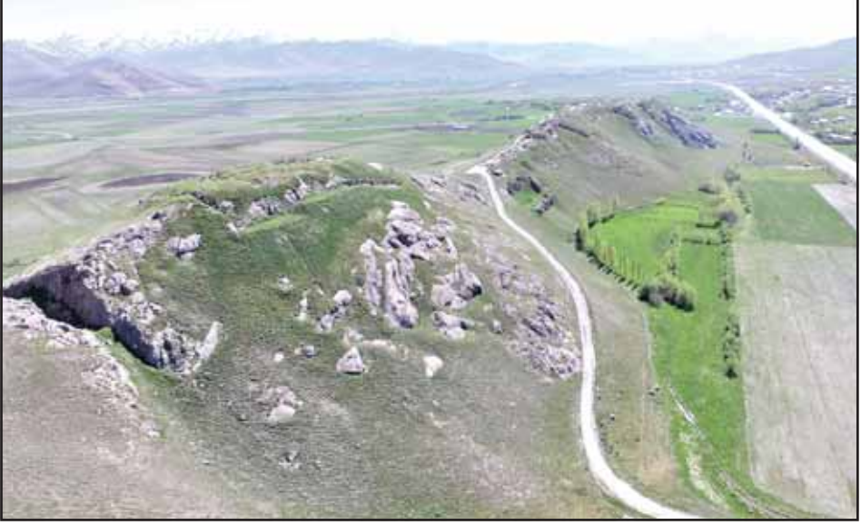
Resim 1: Çavuştepe Kalesi'nin kuzeydoğudan genel görünüşü.
