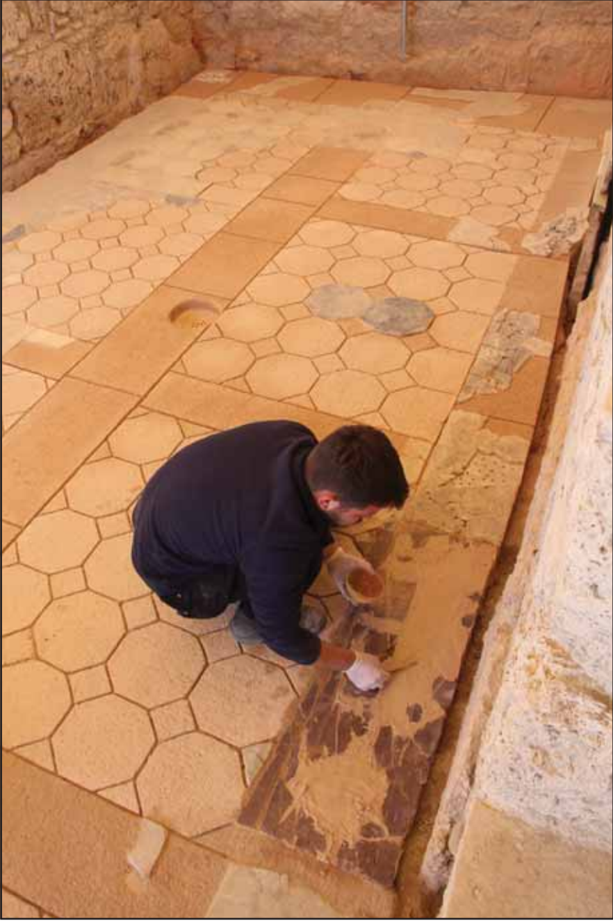
Resim 15: Kiliseli Perstylli Ev, endonartheks (iç narteks) taban döşemeleri üzerinde yapılan restorasyon uygulamaları.
