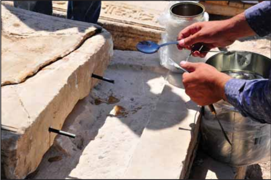
Resim 4: Şahide kaideye yerleştirilirken uygulanan yöntemler.
