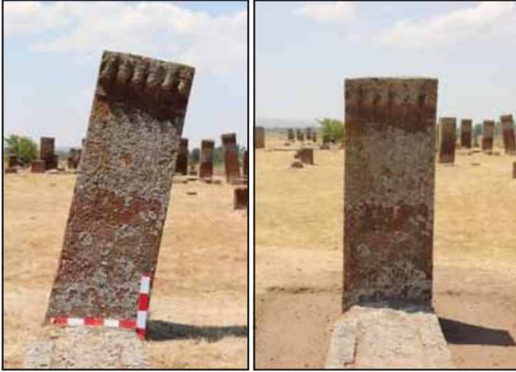
Resim 7-8: Zemin blokajı bozulmuř olan bir řahidenin mřdahale ncesi ve sonrası hali.
