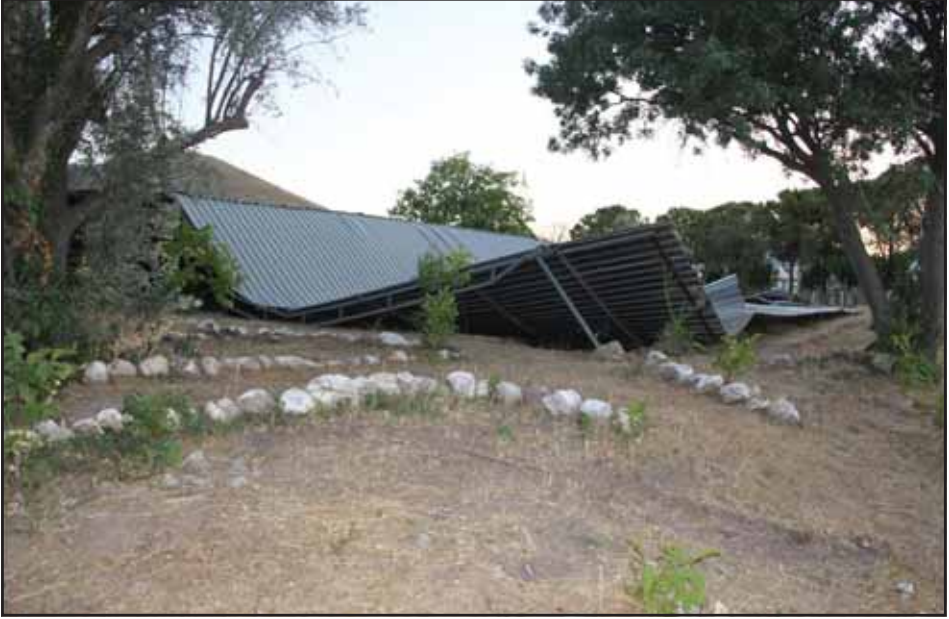
Resim 1: Höyüğün bir bölümü çöken çatı sistemi.
