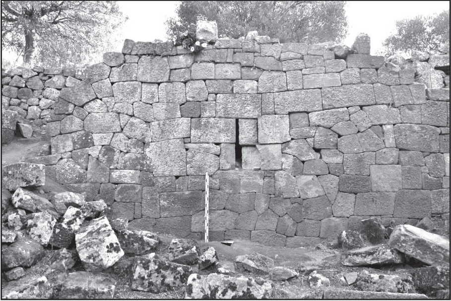
Resim 4: Gymnasion teras duvarının polygonal örgüye sahip kuzeybatı kısmı ve duvar cephesindeki mazgal deliği.
