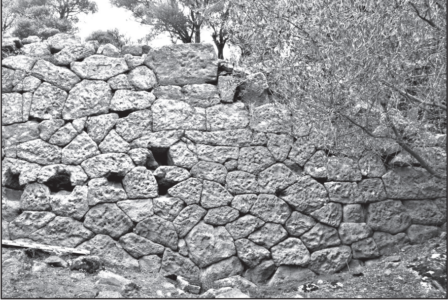
Resim 1: Market binasının güneybatı yakınında yer alan ve Lesbos tipi polygonal örgüye sahip olan duvar.
