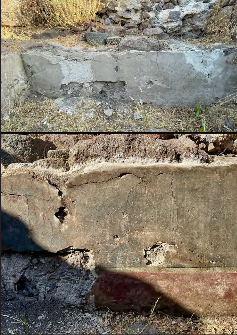
Resim 12: Demirkapı, 5 No.lu Mekân'da yer alan boyalı duvar sıvası, çalışma öncesi ve sonrası durum.
